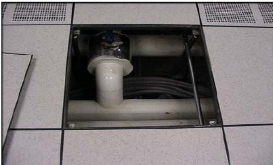
Figura 3. Ejemplo de obstáculos encontrados por el aire frío en el falso suelo (tomado de referencia [2])
